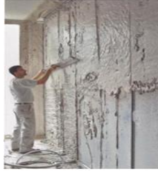
شكل (18) تطبيق PCM plaster على الجدران الداخلية يوفر العزل الحراري
