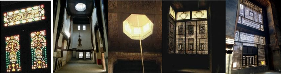
صورة (٣) توضح تطبيق معايير الراحة الإنسانية بتوفير الإضاءة والتهوية الطبيعية وتحقيق الراحة البصرية والحرارية
