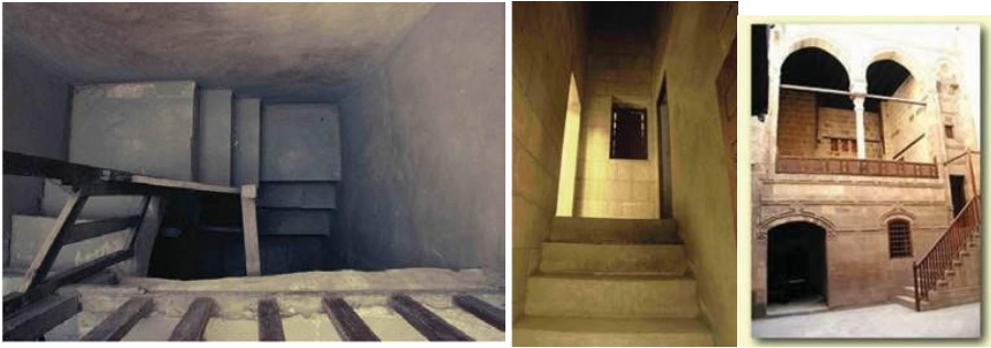
صورة (٥) توضح درجات السلالم الداخلية وارتفاعات الدرج غير ملائمة للمعايير الأرجنومية
