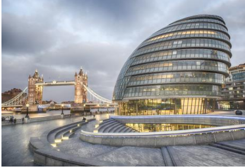
صورة (١٨) توضح مبنى قاعة لندن الذي صممه نورمان فوستر عام ١٩٩٨.
