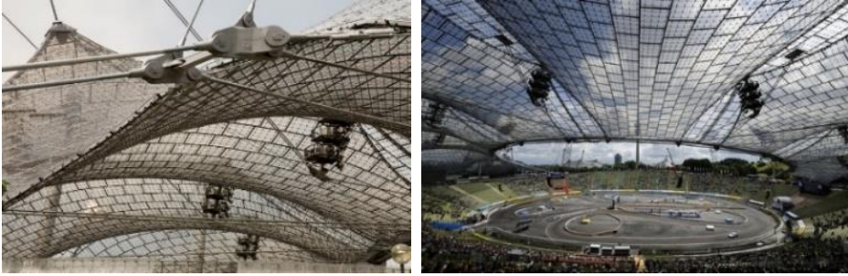
صورة (٣ أ، ب) أ/ توضح الشكل العام للملعب وعلاقة مظلة الكابلات بمنطقة جلوس الجمهور حول الملعب. ب/ توضح النظام الإنشائي لشبكة الكابلات الفولاذية.
