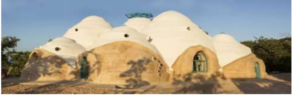
صورة (2) لقطات خارجية لبعض المباني توضح كيفية اختلاف كمية الظلال باختلاف تصميم الكتلة الخارجية للمبنى والتنوع في استخدام المستويات. (خليفة، 2004)
