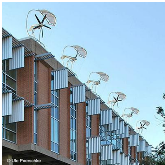
شكل ١٣ يوضح التوربينات على المبني لتوليد الكهرباء للحصول على الإضاءة
